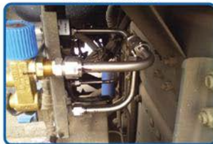
Instalación de sistema para tomas de alto caudal NGV2 y bajo caudal NZ
